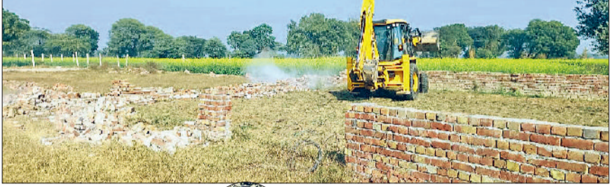
अवैध कॉलोनी का निर्माण तोड़ती जैसीबी।
